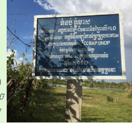
ទំនប់ភ្នំមាស ដែលត្រូវបានស្តារ និងជួសជុល ដោយគម្រោងអង្គការ FLO ដើម្បីដោះស្រាយ ចំពោះកង្វះទឹកសម្រាប់បរិភោគ និងស្រោចស្រព ស្រែចម្ការ ដំណាំបន្លែ និងសត្វពាហនៈ។
